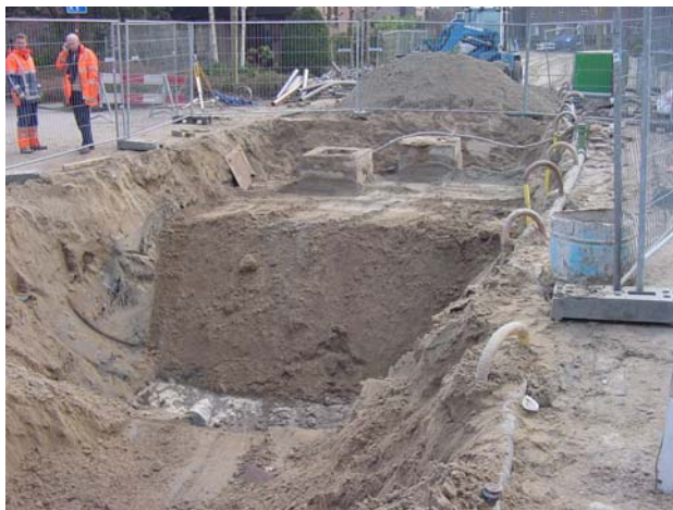
Figuur 5. Voorbeeld van een bronbemaling in de openbare ruimte
